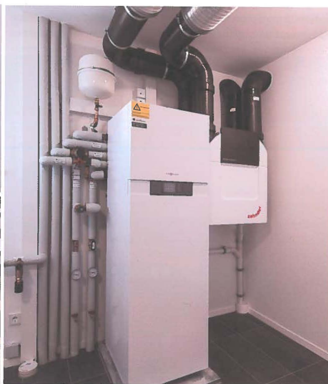
Luft/Wasser-Wärmepumpe mit Warmwasserspeicher, Photovoltaik und eine umfangreiche Regelung sorgen dafür, dass das Musterhaus die Grenzwerte für die Einstufung als KfW-Effizienzhaus 40 Plus einhält
