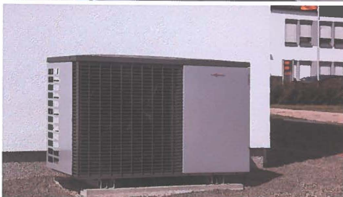
Luft/Wasser-Wärmepumpe mit Warmwasserspeicher, Photovoltaik und eine umfangreiche Regelung sorgen dafür, dass das Musterhaus die Grenzwerte für die Einstufung als KfW-Effizienzhaus 40 Plus einhält
